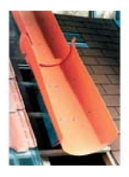
Permet l'évacuation de matériaux de couverture Se raccorde en partie basse à un entonnoir multi-fonctions
