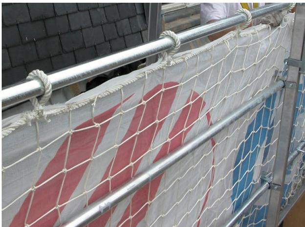
Les planchers, lisses, plinthes et filets se posent sur les consoles et garde-corps pour venir sécuriser le travail sur l'échafaudage.
