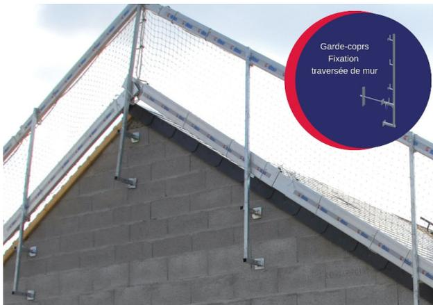
Les gardes-corps se fixent en rive ou en bas de toit et reçoivent les accessoires de sécurité (lisses, plinthes, filets) pour constituer une protection complète.
