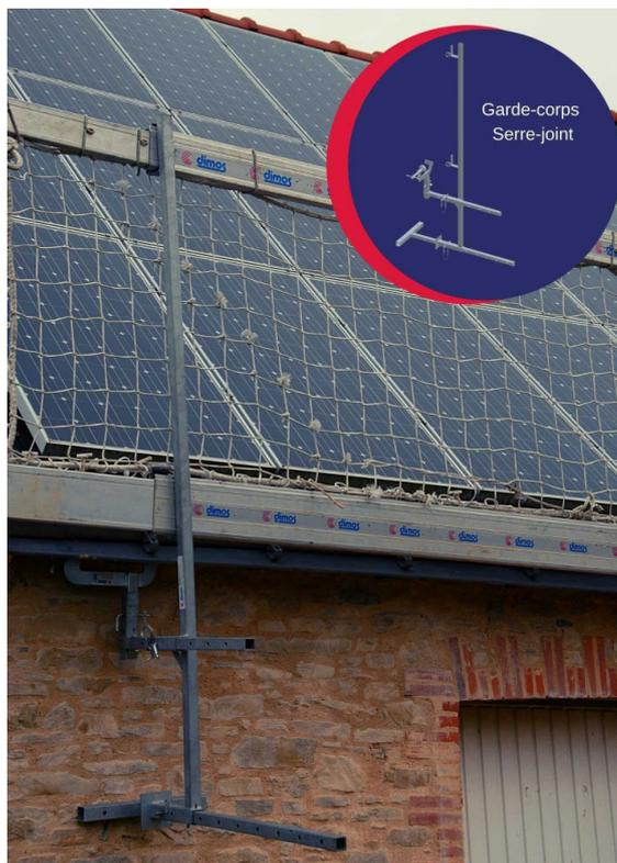
Les gardes-corps se fixent en rive ou en bas de toit et reçoivent les accessoires de sécurité (lisses, plinthes, filets) pour constituer une protection complète.
